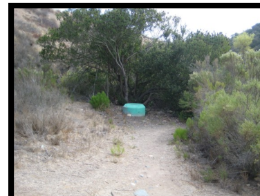
16. Manhole #147 32° 48.03 N 117° 10.41 W
