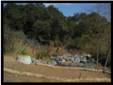
11. Manhole #216 32° 47.91 N 117° 10.71 W
