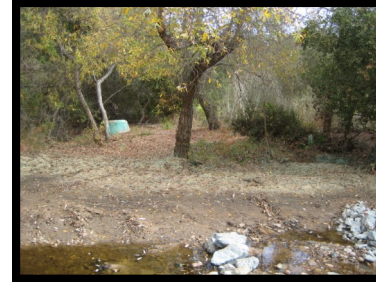
15. Manhole #146 32° 48.00 N 117° 10.50 W
