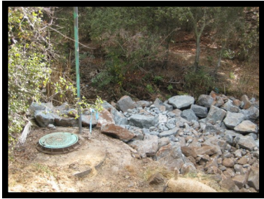
9. Manhole #215 32° 47.88 N 117° 10.79 W
