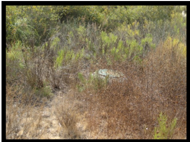
13. Manhole #225 32° 47.96 N 117° 10.62 W
