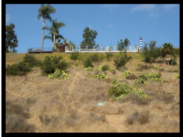
10. Manhole #214 32° 47.92 N 117° 10.77 W
