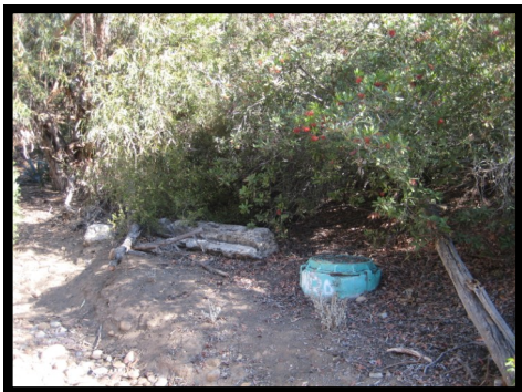
13. Manhole #20 32° 44.19 N 117° 07.59 W
