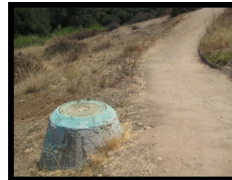
17. Manhole #190 N 32° 50' 42", W 117° 11' 9"
