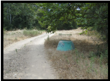
13. Manhole #188 N 32° 50' 42", W 117° 11' 20"
