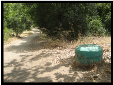
10. Manhole #185 N 32° 50' 41", W 117° 11' 31"
