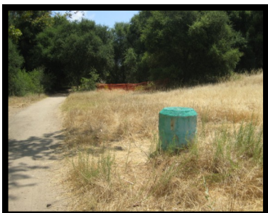
14. Manhole #189 N 32° 50' 41", W 117° 11' 17"
