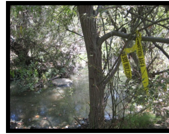
15. Manhole #192 N 32° 50' 44", W 117° 11' 14"
