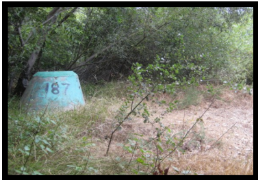
12. Manhole #187 N 32° 50' 41", W 117° 11' 24"
