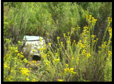
10. Manhole #497 N 32° 50' 8", W° 117 14' 0"
