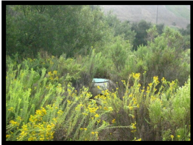
11. Manhole #83 32° 50' 8" N 117° 14' 0" W
