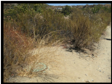
14. Manhole #13 32° 49' 25" N 117° 3' 20" W
