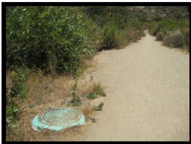
13. Manhole #4 32° 49' 26" N 117° 3' 23" W
