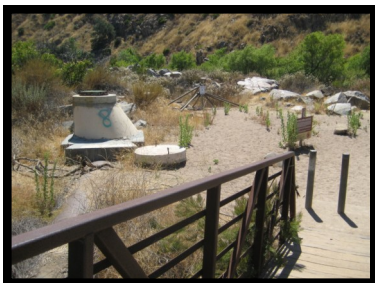
22. Manhole #8 32° 50' 25" N 117° 13' 8" W
