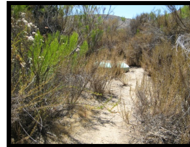
17. Manhole #16 32° 49' 20" N 117° 3' 22" W
