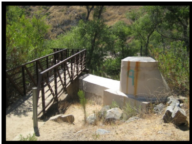
21. Manhole #9 32° 50' 20" N 117° 2' 42" W
