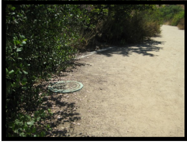
19. Manhole #13 32° 50' 23" N 117° 2' 37" W
