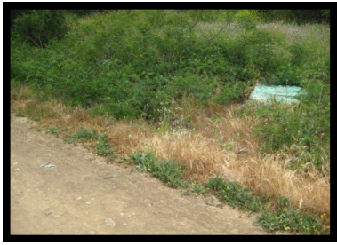
10. Manhole #7 32° 56' 12" N 117° 08' 27" W
