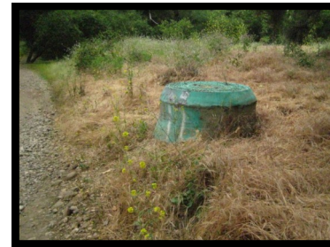
17. Manhole #17 32° 56' 14" N 117° 08' 51" W
