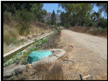
13. Manhole #47 32° 47' 44" N 117° 2' 20" W
