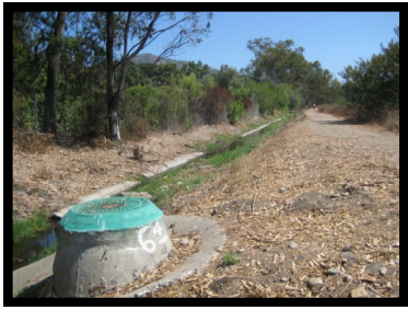
10. Manhole #44 32° 47' 37" N 117° 02' 25" W
