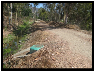
12. Manhole #46 32° 47' 41" N 117° 02' 21" W
