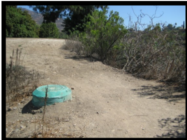
14. Manhole #96 32° 47' 47" N 117° 02' 17" W
