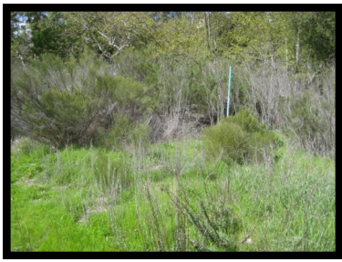
9. Manhole #108 32° ___' ___" N 117° ___' ___" W
