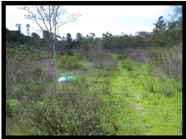
11. Manhole #110 32° ___' ___" N 117° ___' ___" W
