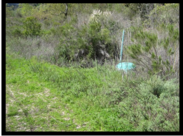
10. Manhole #109 32° ___' ___" N 117° ___' ___" W
