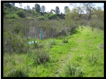
12. Manhole #112 32° ___' ___" N 117° ___' ___" W
